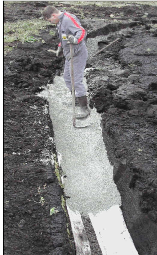
Eksempel på en steinsil. Bruk helst grov singel (16-32) (Evt løs leca i nettingsekker) IKKE jord oppå. For ytterligere å bedre vasstransporten kan en koble på et stykke drensør og la det gå opp gjennom singelen. Husk lokk.
