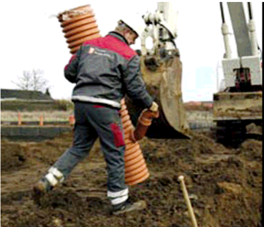
Eksempel på nedløpskum i plast. Kombineres med en flat rist oppå.
